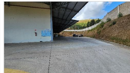
Galpão novo | Fonte: GT
