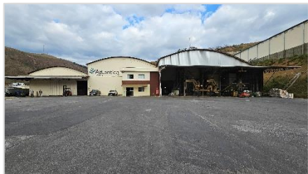
Entrada | Fonte: GT
