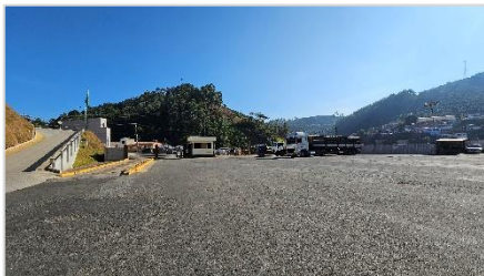
Entrada | Fonte: GT
